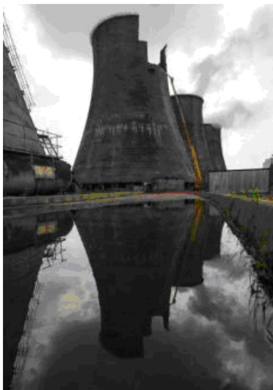
Рис. 21. ТЭЦ-16: демонтаж градирни № 2
