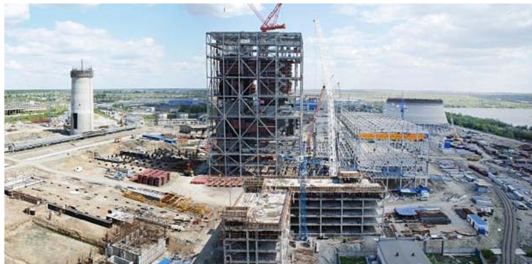
Рис. 33. Строительство нового пылеугольного энергоблока на Троицкой ГРЭС
