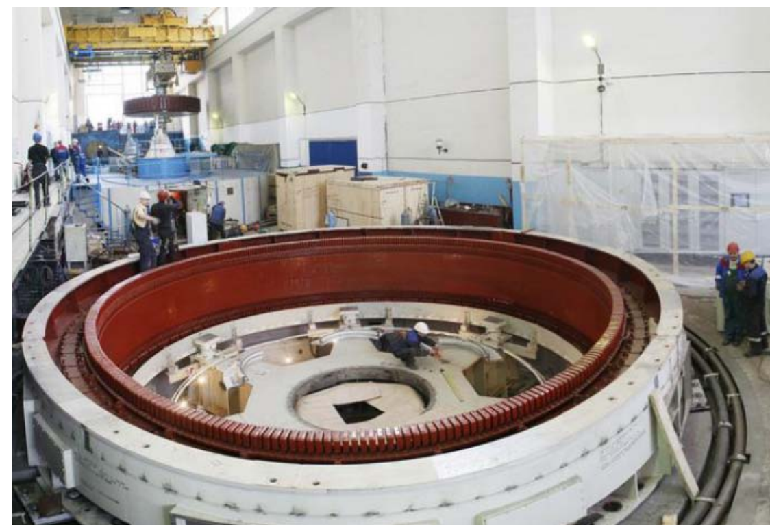
Рис. 26. Установка ротора гидроагрегата № 3 на Лесогорской ГЭС
