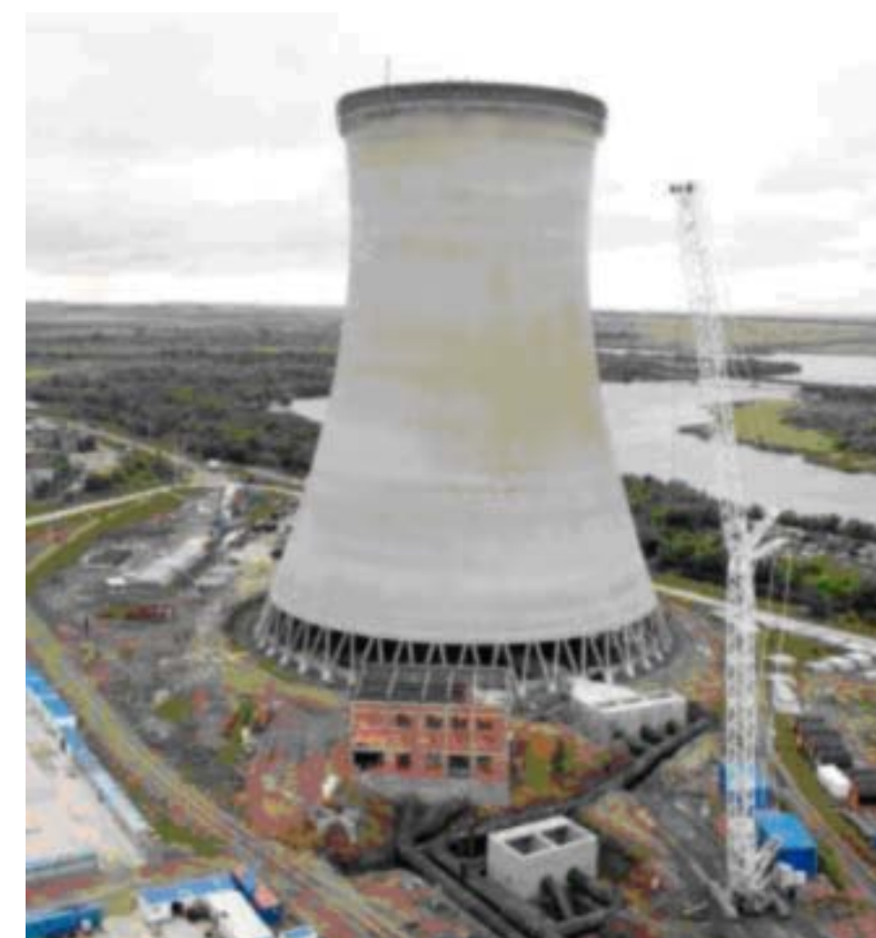
Рис. 23. Бетонирование корпуса башенной градирни на Троицкой ГРЭС
