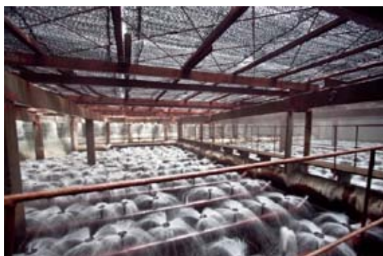
Рис. 41. Система охлаждения в паротурбинной электростанции (ТЭЦ-26)
