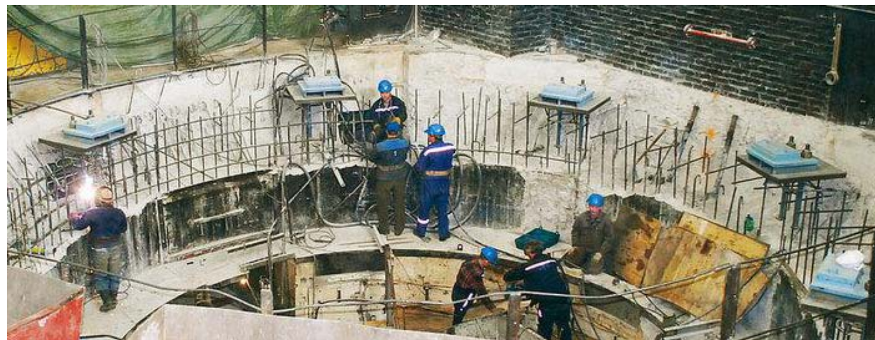
Рис. 25. Монтаж гидроагрегата № 3 на Лесогорской ГЭС
